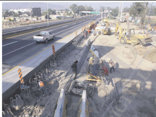
ANTES DE LO PREVISTO. El tráfico a la altura de El Mante ya es más fluido. Los carriles se abrieron dos semanas antes del plazo fijado y se continuará trabajando en la construcción del retorno.
